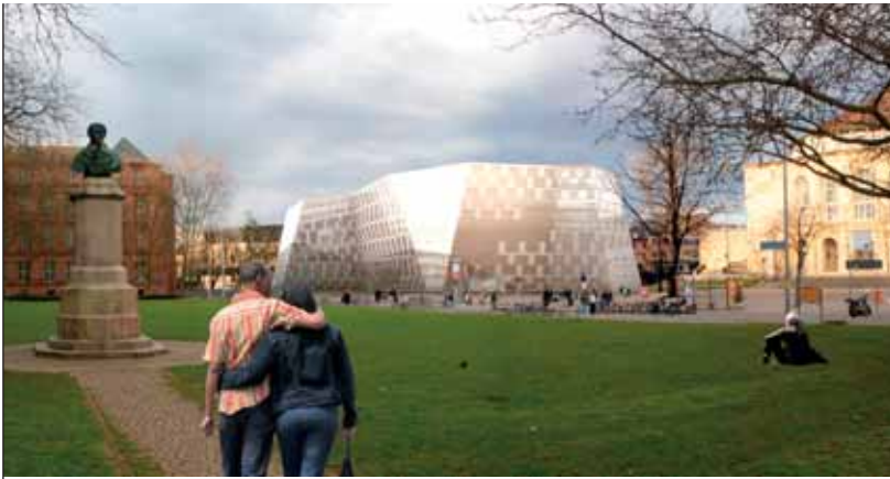
Die neue UB (Entwurf: Degelo Architekten Basel) ist das markanteste Gebäude am Platz der Alten Synagoge – und macht die Umgestaltung desselben erst nötig.
