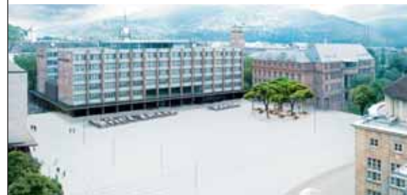
Nur zweiter Sieger: Der Entwurf der Arbeitsgemeinschaft Henne, Korn, Meier, Sacker wollte alle vorhandenen Bäume fällen ...
