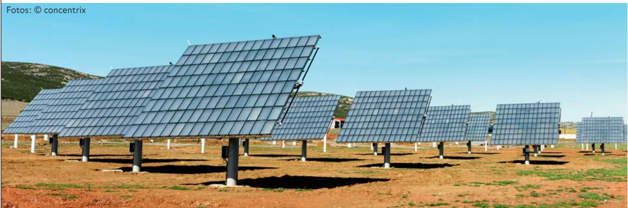
Extrem hohe Wirkungsgrade: Die Freiburger konzentrieren Sonnenlicht, um noch mehr sauberen Strom zu produzieren, wie hier im Solar Kraftwerk in Puertollano.
