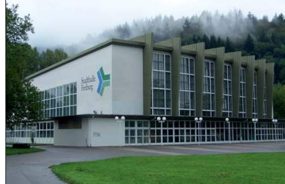
Denkmal Stadthalle: Im Osten werden die Weichen für die Zukunft bereits gestellt. Hier könnte ein neues Musikzentrum entstehen. Foto: © gegi
