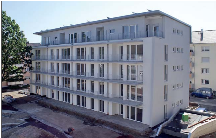
Genossenschaftlicher Neubau: 24 neue Wohnungen des Bauvereins in der Antoniterstraße.
