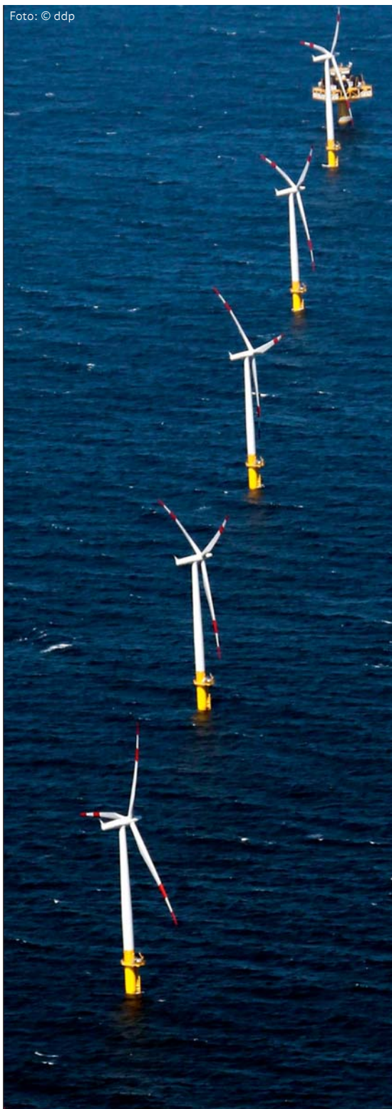
Windfänger: Mit Baltic 1 ist der erste Off-shore-Windpark ans Netz.
