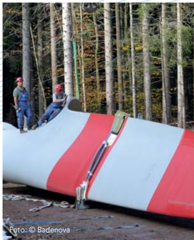
Schwergewicht: 4,5 Tonnen wiegt ein Flügel der alten Freiburger Windräder. Ein neuer E-126-Flügel wiegt 70.
